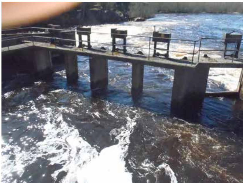
Figur 3. Fiskvägens nedre ingång med de fem ingångarna med luckorna nedsänkta utan regleringsmöjlighet. Foto: Stefan Stridsman.
