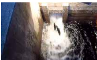
Figur 8. Installation av den falska tröskeln där fisk simmar in. Foto: Stefan Stridsman
