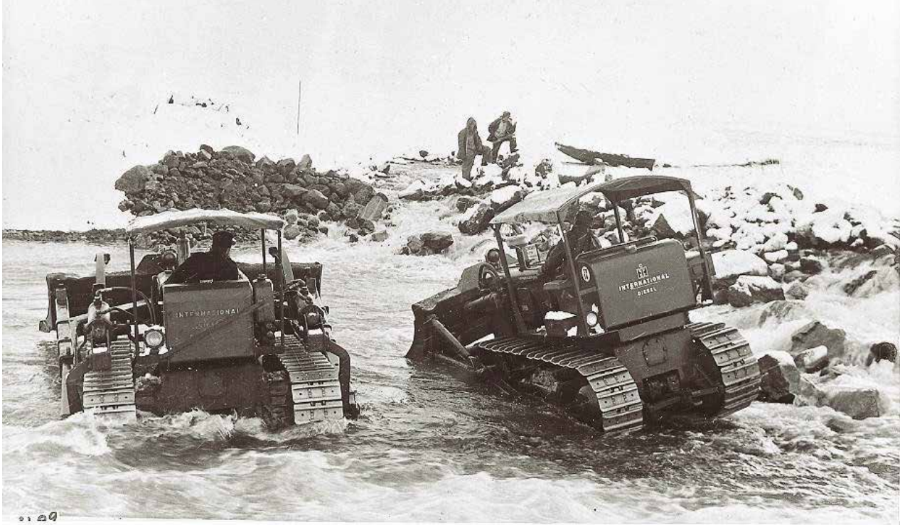
Figur 33. Flottningsrensning med bulldozer. Foto Johan Brun.
