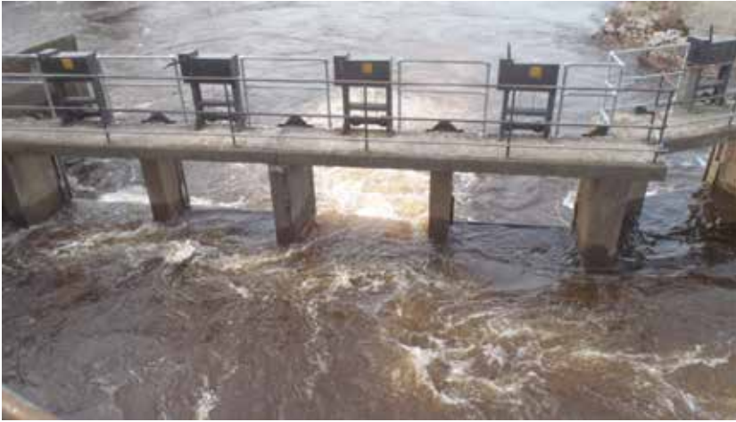
Figur 5. De fem ingångarna med reparerade justeringsanordningar för höjdjustering av luckorna för styrning av vattenutflödet samt vattenarean i fiskvägsmynningen. Foto: Stefan Stridsman.
