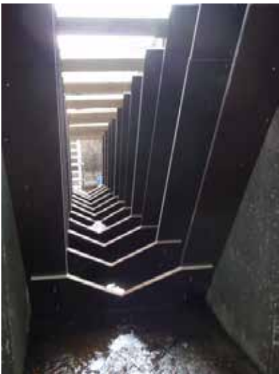
Figur 6. Installation av lameller i fiskvägens denilsektion. Foto: Tomas Utter.
