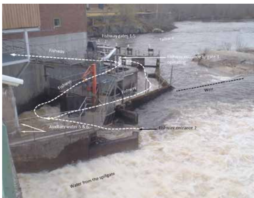
Figur 1. Forshaga fiskväg med de olika ingångarna. Foto: Stefan Stridsman
